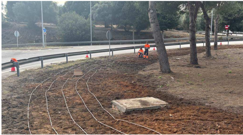
Instalación del sistema de riego por goteo.
