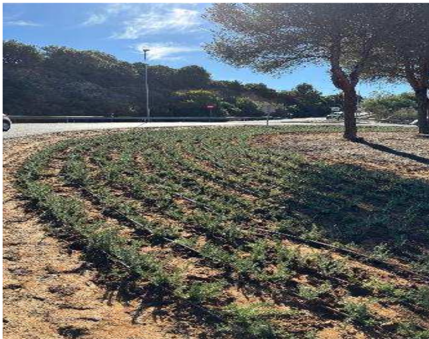
Instalación del sistema de riego por goteo.
