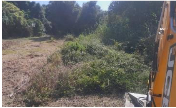
Ejemplo de labores de desbroce con retroexcavadora y desbrozadora.
